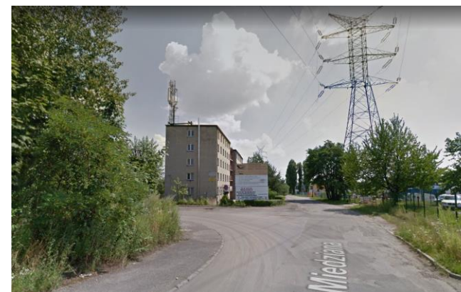
WJAZD NA TEREN INWESTYCJI Z UL. MIEDZIANEJ
